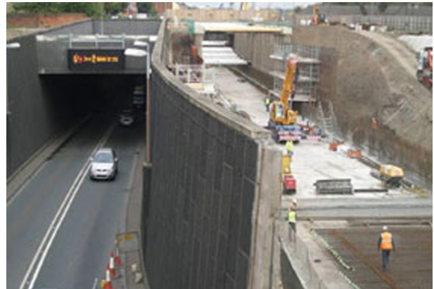
(d) New Tyne Tunnel, Newcastle, UK
